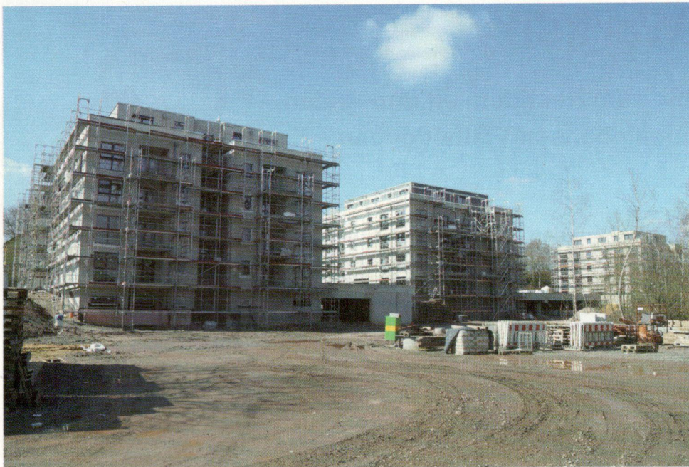
Das dritte Projekt im Knappenroth steht vor der Fertigstellung.
